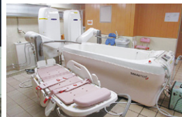
改修による新設特殊浴槽
