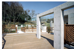
屋上ウッドデッキ
